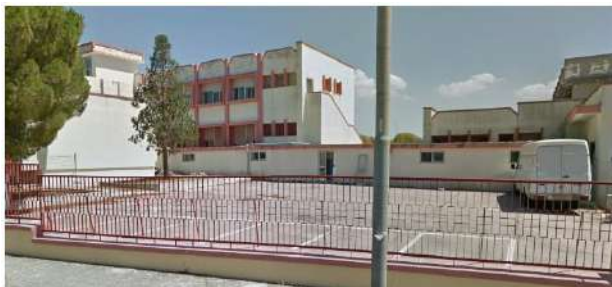
Foto 8 Prima della demolizione del tunnel
