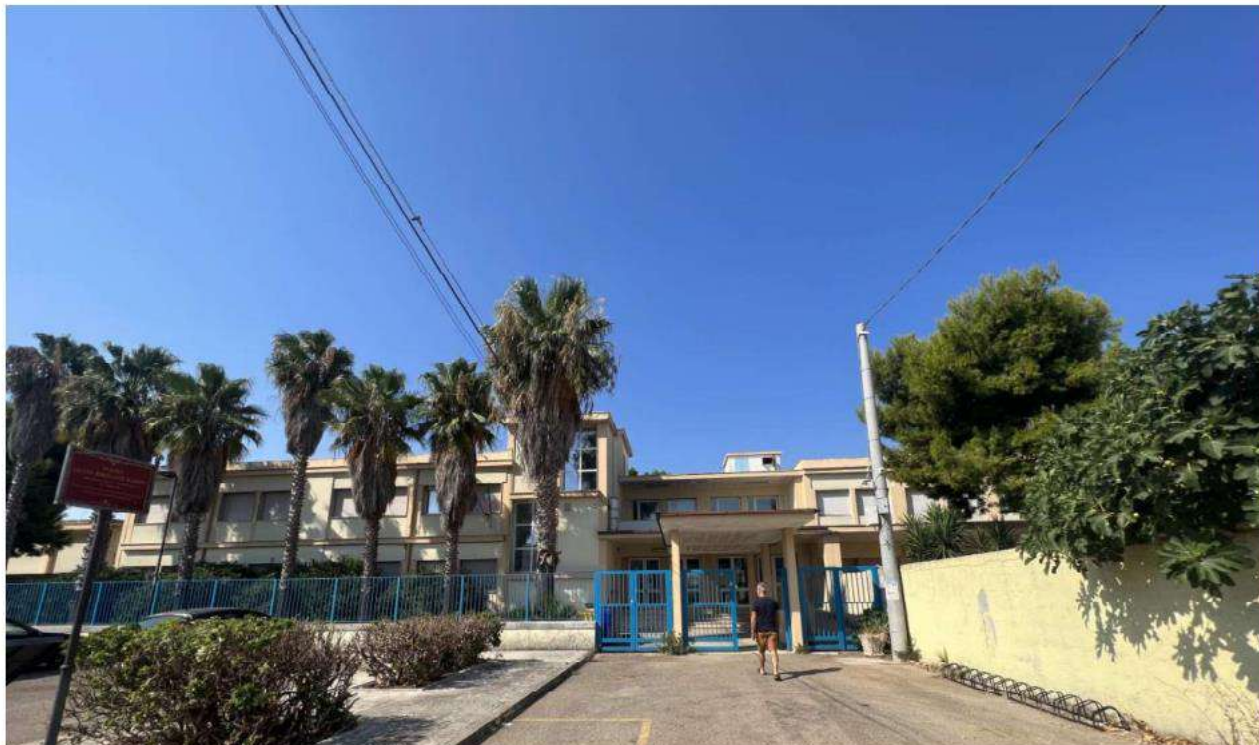
Foto n.2 – Prospetto principale e ingresso edificio scolastico in Via I Maggio
