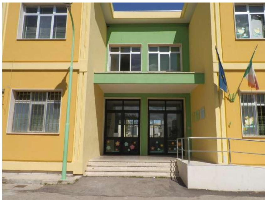
Figura 6: Ingresso scuola Via Crispi (ARES 0750520133)
